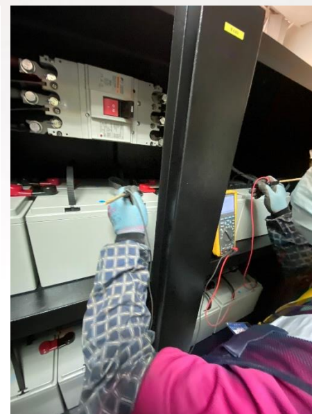
維護 電池組數據電壓的檢查
